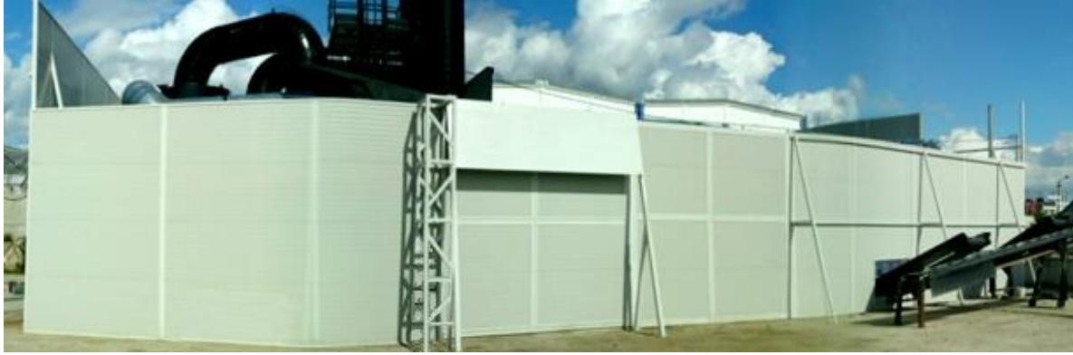
Εικόνα 10: Παράδειγμα χρήσης ηχοπετασμάτων σε σταθερές πηγές θορύβου
